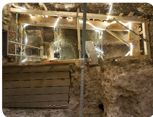
◀ Fouilles Opération en cours avec le rempart de l'Antiquité tardive dans la moitié inférieure de l'image. © Archeodunum
