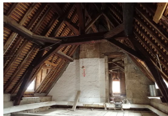
▲ Charpente de l'hôtel Lacomme
