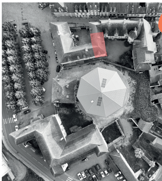
▲ Vue aérienne de la zone avant les travaux
