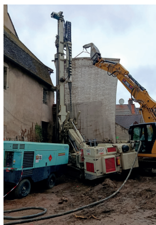
▲ Intervention d'une foreuse pour la pose des fers
