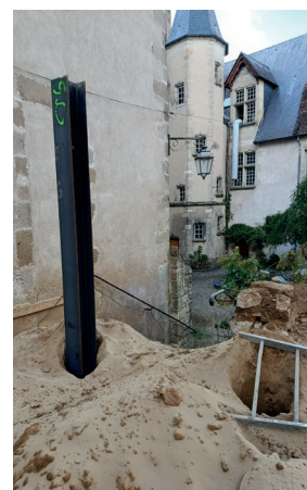
▲ Intervention d'une foreuse pour la pose des fers
