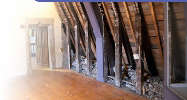
▲ Charpente de toit visible au deuxième étage de l'hôtel Rolin après la dépose des doublages
