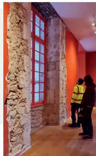
◀ Une fenêtre de l'hôtel Lacomme après la dépose des enduits
