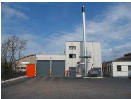
Chaufferie PASA – Avril 2013
