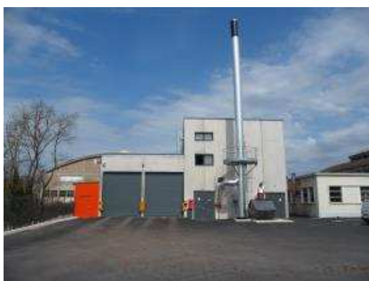
Chaufferie PASA – Avril 2013
