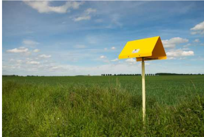
Balise de signalisation canalisation gaz
