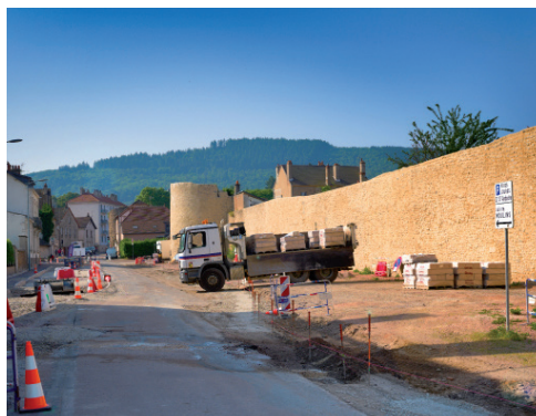
Boulevard Laureau mise en valeur des remparts
