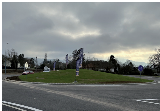
Nouveau rond-point ZI de St-Pantaléon travaux menés par les services du département 71
