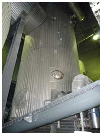
Le combustible biomasse utilisé est constitué à 50% d'écorces criblées et à 50% de chutes/sous-produits.
